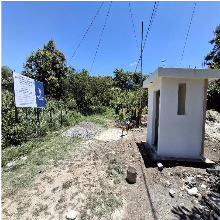
MEJORAMIENTO SISTEMA DE AGUA POTABLE COLONIA CHICUXTIN CUBULCO, BAJA VERAPAZ. SNIP 335604. AVANCE FÍSICO 82.50%
