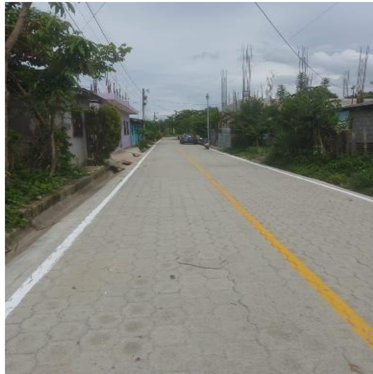
MEJORAMIENTO CAMINO RURAL COLONIA EL NARANJO CUBULCO, BAJA VERAPAZ. SNIP 328276. AVANCE FÍSICO 100%
