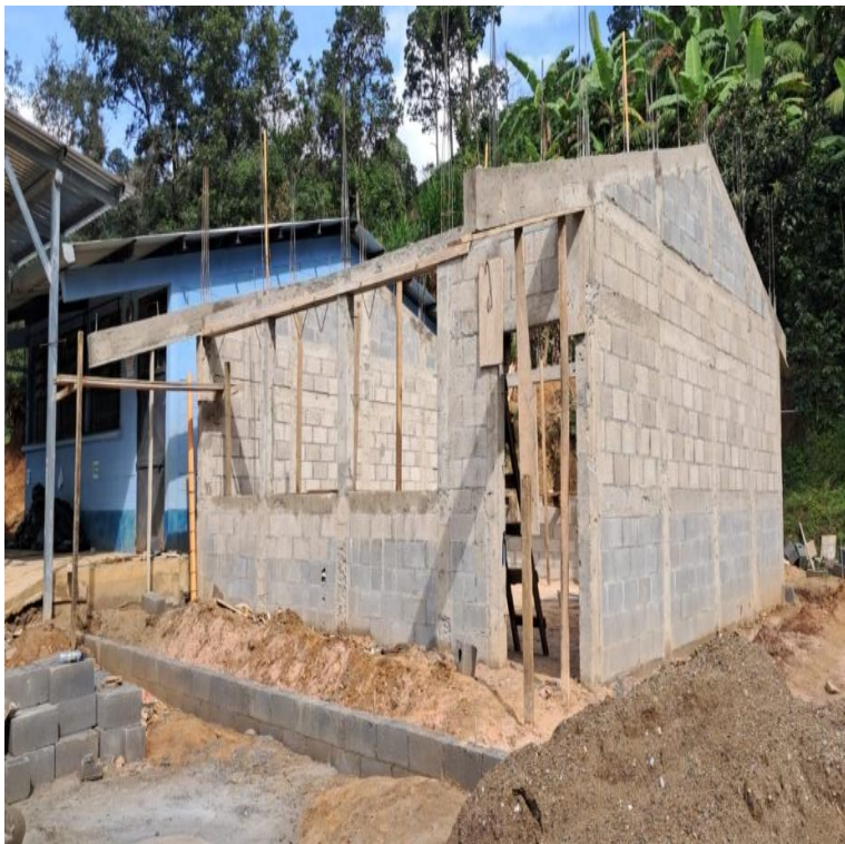
AMPLIACION ESCUELA PRIMARIA CASERIO LLANO ALDEA SANTA ROSA CUBULCO, BAJA VERAPAZ. SNIP 332229. AVANCE FÍSICO 44.56%
