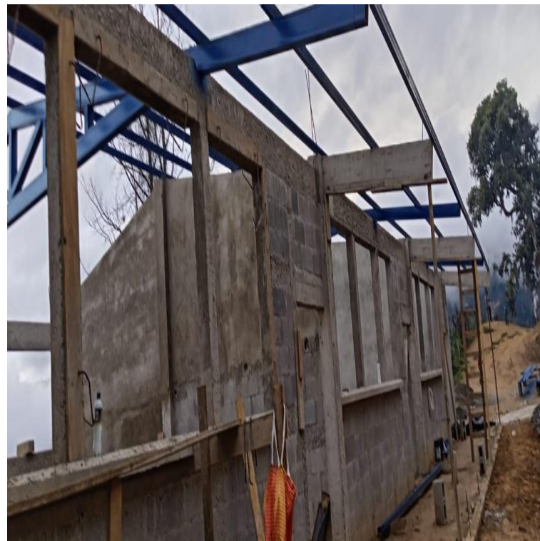
CONSTRUCCION ESCUELA PRIMARIA CASRIO TURBALA CUBULCO, BAJA VERAPAZ. SNIP 332247. AVANCE FÍSICO 50.04%
