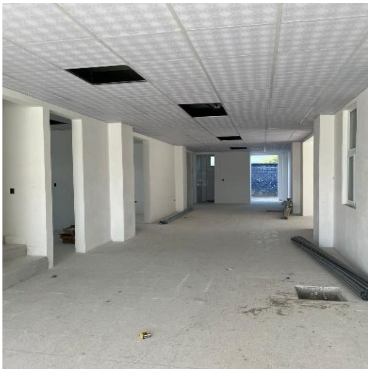
AMPLIACION CENTRO DE SALUD BARRIO AGUA CALIENTE SALAMA, BAJA VERAPAZ. SNIP 315965. AVANCE FÍSICO 76.84%
