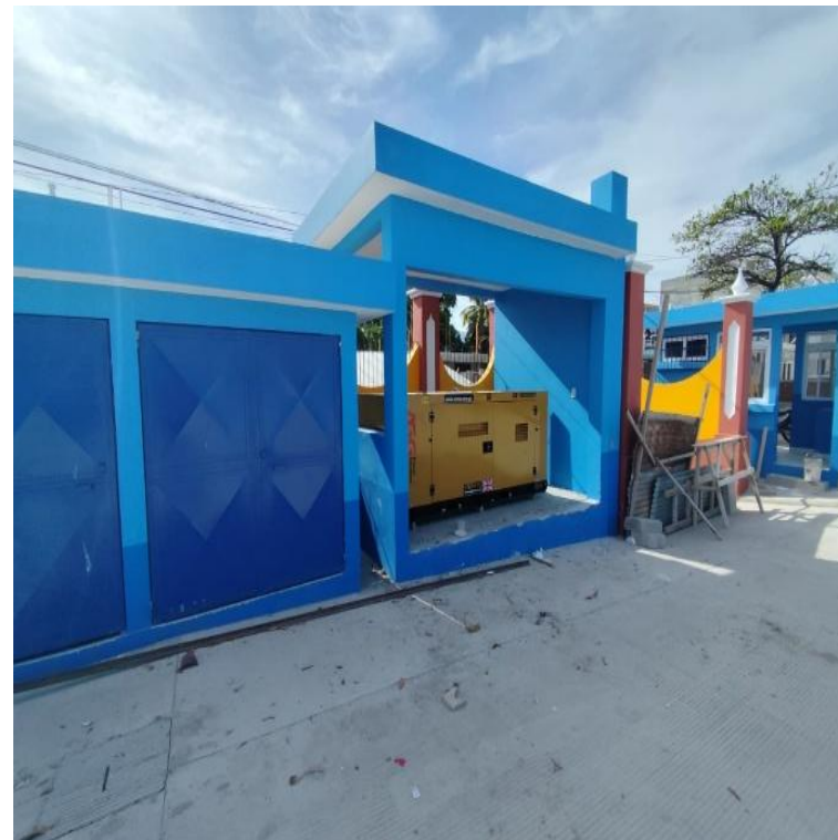
MEJORAMIENTO CENTRO DE SALUD ZONA 3 RABINAL, BAJA VERAPAZ. SNIP 315709. AVANCE FÍSICO 90.45%
