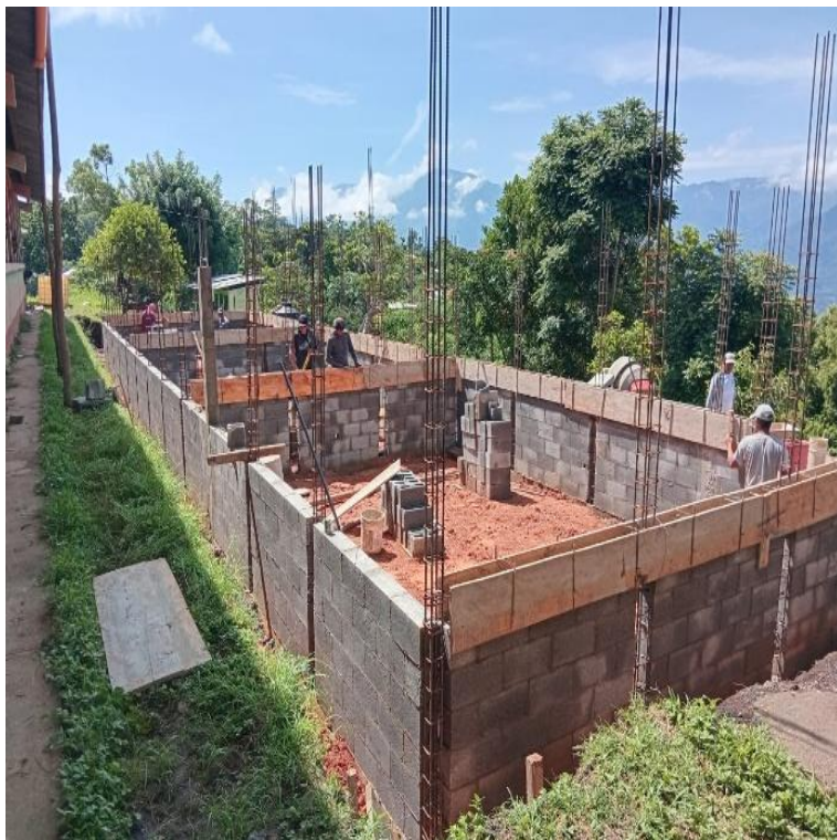
AMPLIACION ESCUELA PRIMARIA ALDEA ESFUERZO CHEJEL PURULHA, BAJA VERAPAZ. SNIP 332782. AVANCE FÍSICO 15.92%
