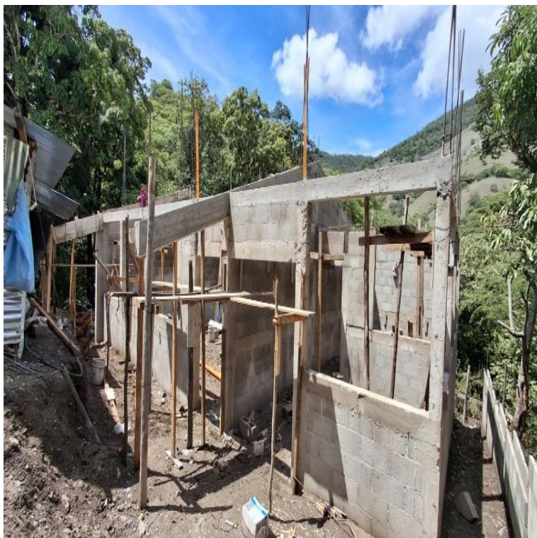
CONSTRUCCION ESCUELA PRIMARIA CASERIO XUAXAN ALDEA LOS PAJALES CUBULCO, BAJA VERAPAZ. SNIP 332256. AVANCE FÍSICO 23.44%.
