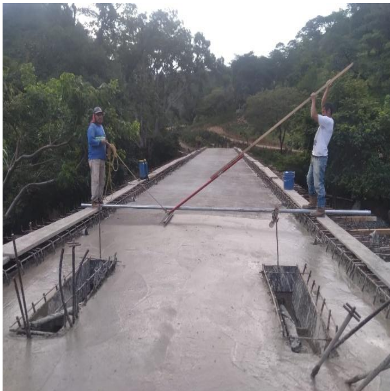
CONSTRUCCION PUENTE VEHICULAR CASERIO VEGA GRANDE CUBULCO, BAJA VERAPAZ. SNIP 332027. AVANCE FÍSICO 90.96%
