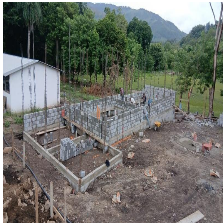
CONSTRUCCION ESCUELA PRIMARIA CASERIO VISTA HERMOSA PURULHA, BAJA VERAPAZ. SNIP 332771. AVANCE FÍSICO 14.37%
